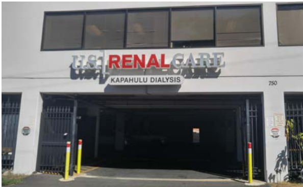
(カパフル透析センターの外観)
